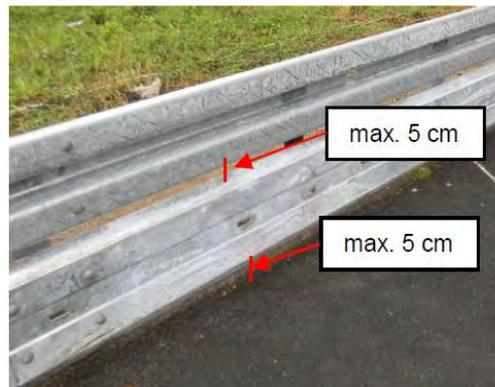
**Réglage de la hauteur d'installation de l'écran de protection des motards (MPS)** à l'aide de la lumière oblongue dans le bras d'écran, de manière à ce que les écarts entre :
